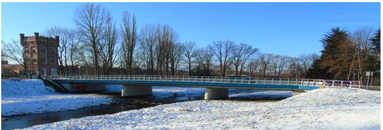
Rys. 1.2. Widok na most od strony wody górnej
