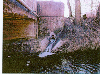
Wylot kanalizacji po stronie prawej. Skrzydło podpory nr 2.
