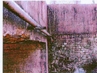
Ściana oporowa przy podporze nr 2 po stronie prawej
